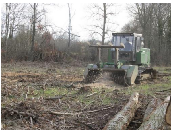
Photo 2 : Illustration de travaux d'ouverture de plantation
